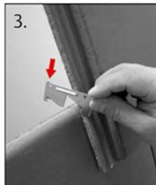
3. Alternative: Klammer auf Seitenfalz setzen und nach unten drücken.
